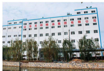
天邦面业日处理小麦1000T生产线 Tianbang Flour Processing Wheat 1000TPD Production Line
